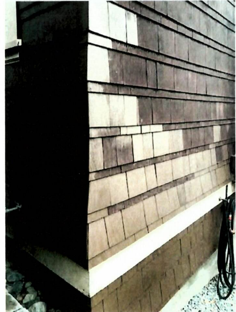
1231 Montrose Av shingle siding repairs
