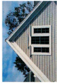
A. Wood Shingles
